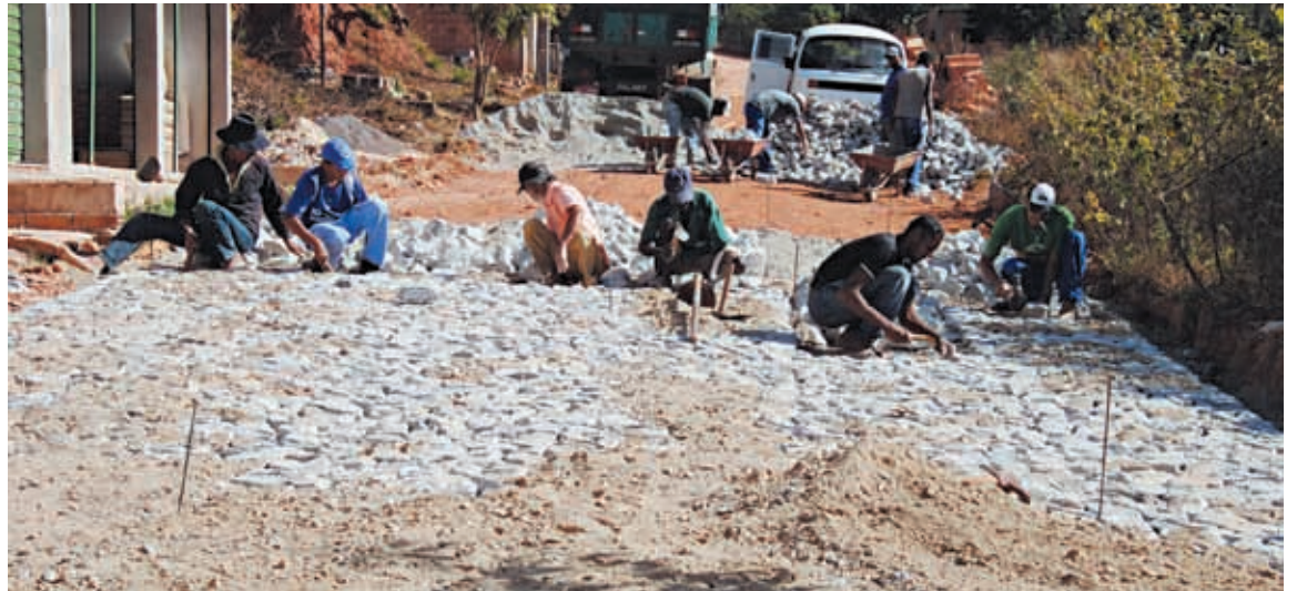
Calçamento rua Dália, Vale das Acácias
