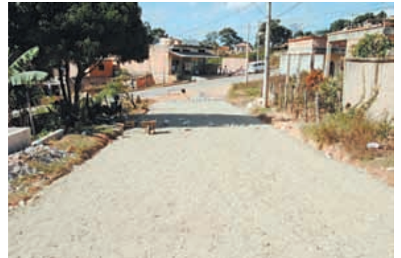
Calçamento rua Dália, Vale das Acácias
