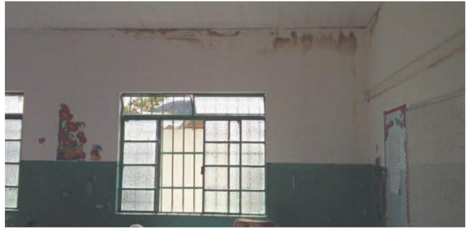
Paredes com infiltrações e mofadas...
