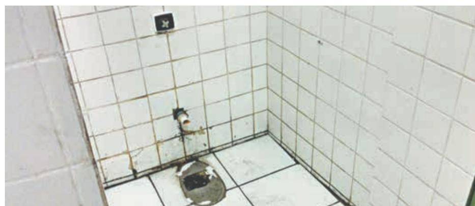
...onde deveria haver um vaso sanitário, apenas parte da instalação hidráulica
